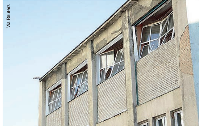
Ударная волна, достигшая поверхности Земли через несколько секунд после взрыва, повредила множество строений в Челябинске и окрестностях (некоторые — достаточно серьезно).
